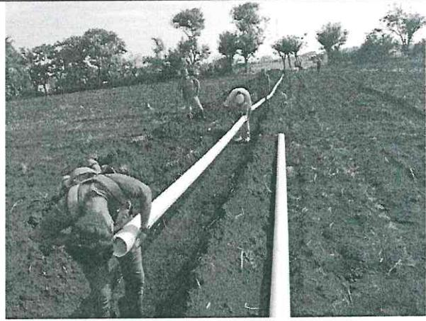
Instalación de tubería para sistema de riego por aspersión
