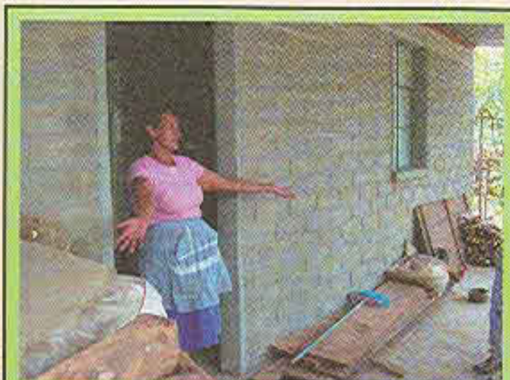
Vivienda construida con block de terracreto, a base de arena blanca, arena amarilla y cemento, con la participación directa de los beneficiarios, al producir sin necesidad de energía eléctrica la cantidad necesaria de block.
