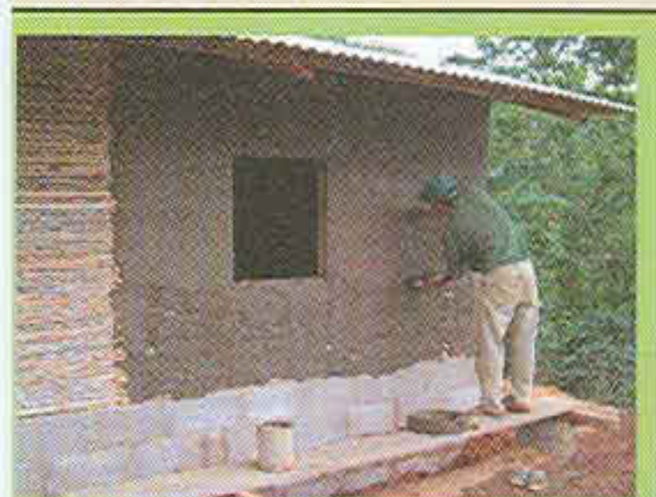
Construcción de vivienda rural haciendo uso del bambú como soporte de pared, a través de la ayuda del Banco Mundial, vía Cooperación Externa del Fondo de Tierras
