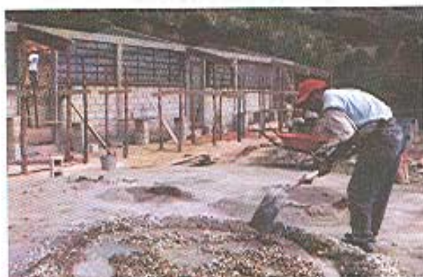
Construcción de la escuela en la Finca Ixcoyán, ubicada en Salamá, Baja Verapaz.
